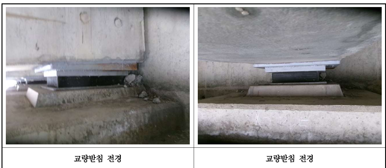
【사진 1.3.12】 교량받침 전경
