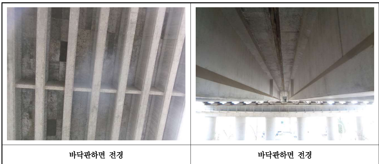
【사진 1.3.2】 바닥판하면 전경
