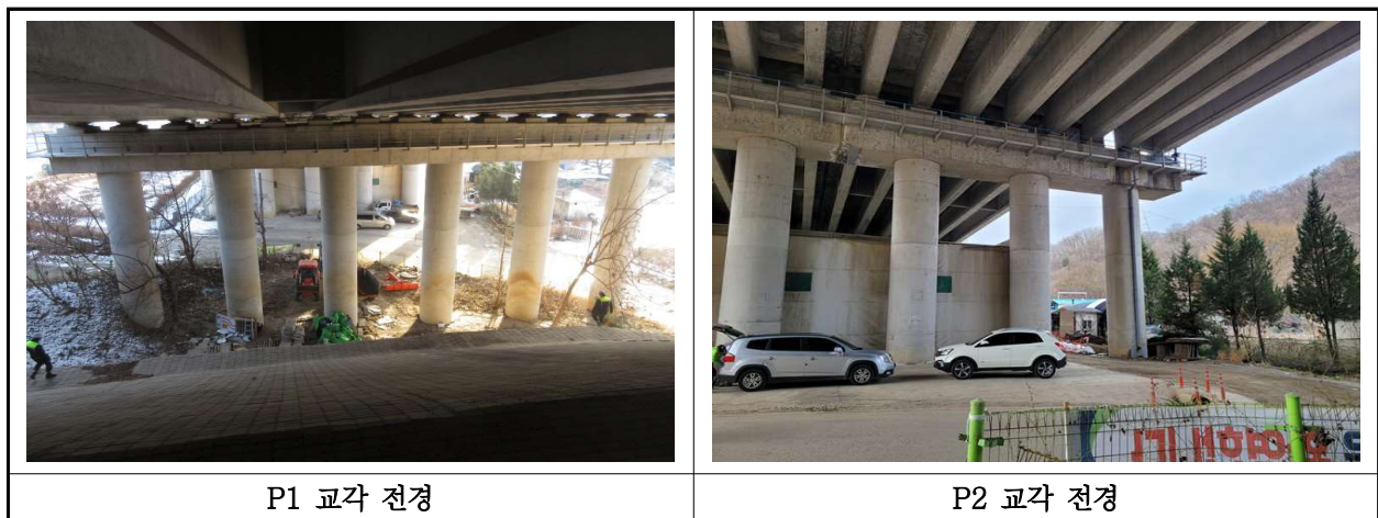
【사진 1.3.10】 교각 전경
