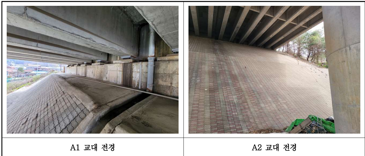
【사진 1.3.8】 교대 전경
