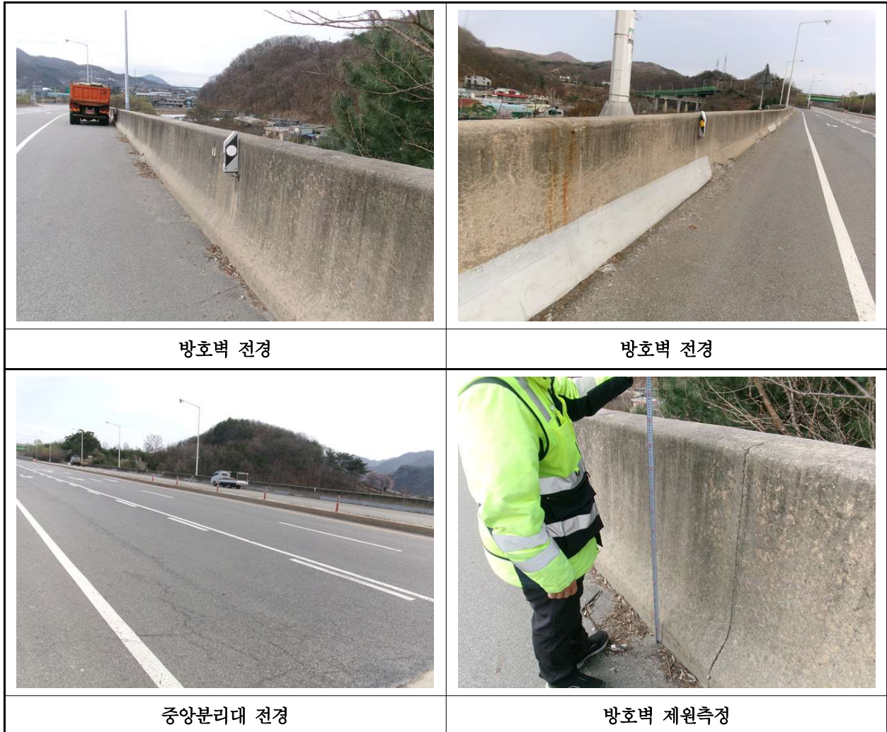
【사진 1.3.21】 난간 및 연석 전경
