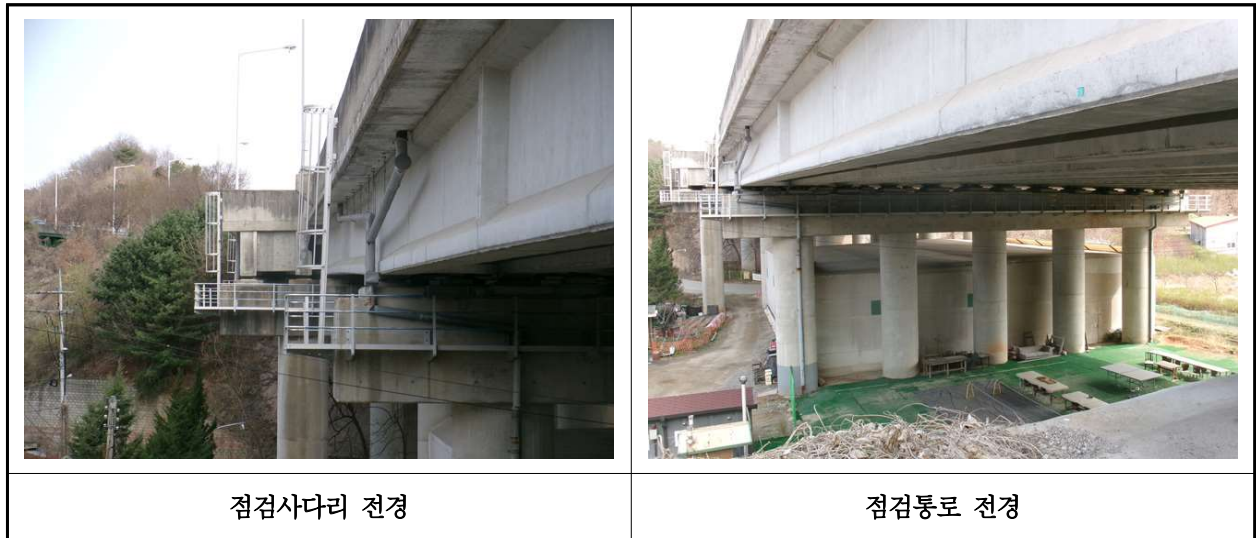
【사진 1.3.23】 교량 점검시설 전경
