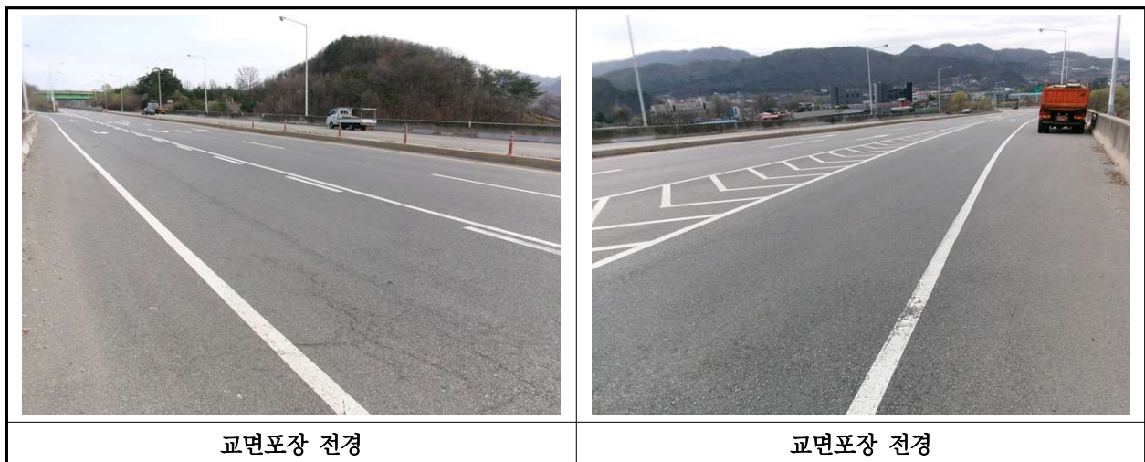
【사진 1.3.17】 교면포장 전경
