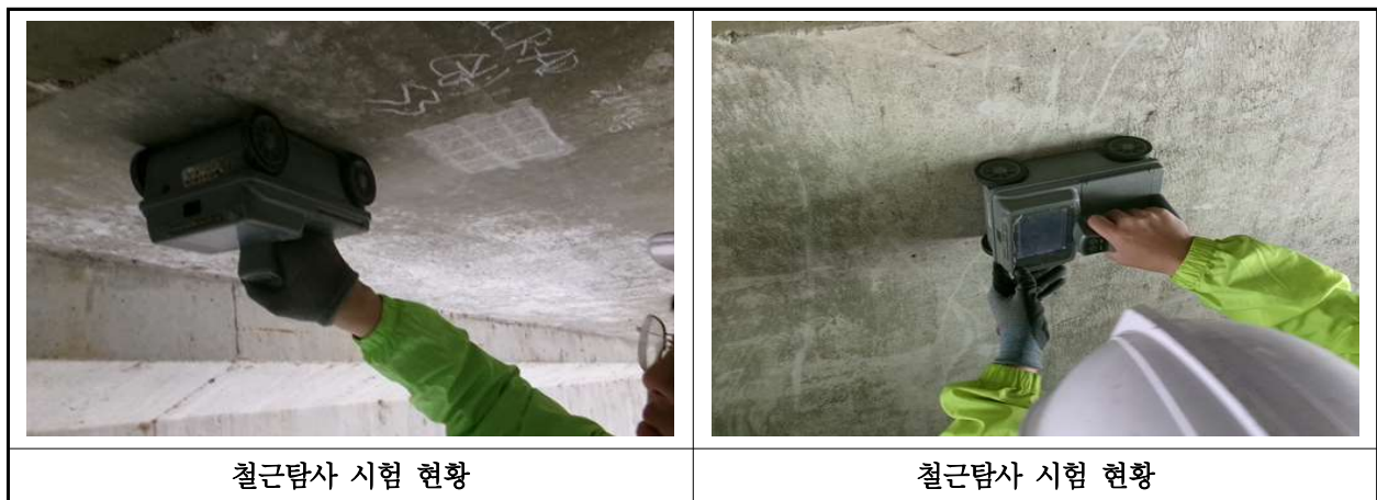
【사진 1.4.2】 철근탐사 시험
