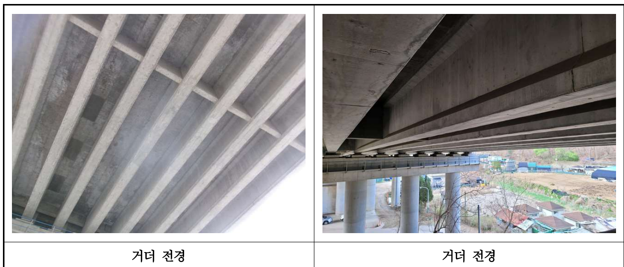
【사진 1.3.4】 거더 전경
