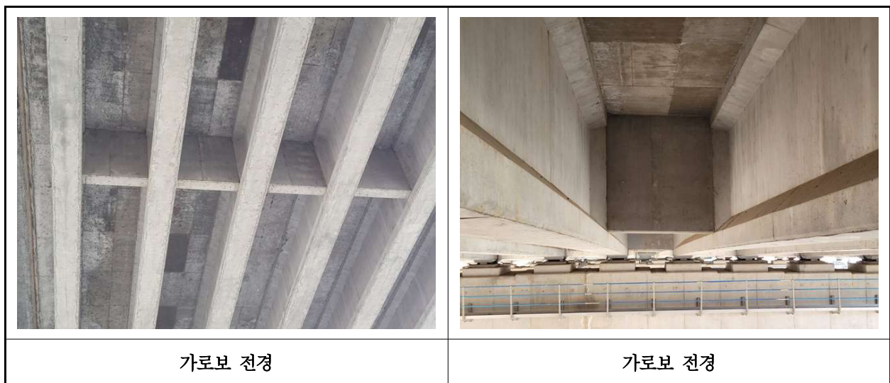
【사진 1.3.6】 가로보 전경
